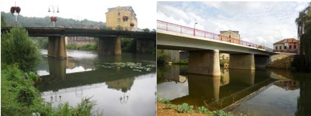
L'ouvrage avant / après
